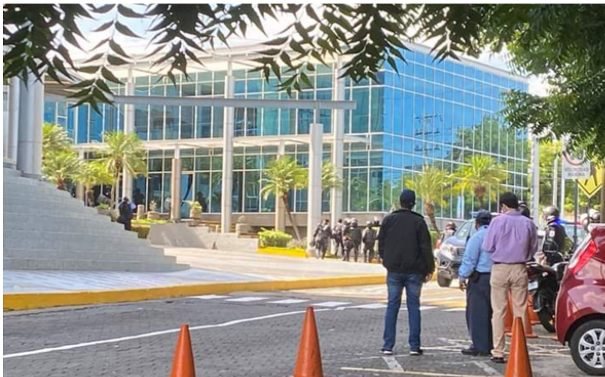
Agentes policiales allanan la sala de redacción de Confidencial ubicada en el Edificio IVERCASA. (Foto: Confidencial 20 de mayo 2021)
